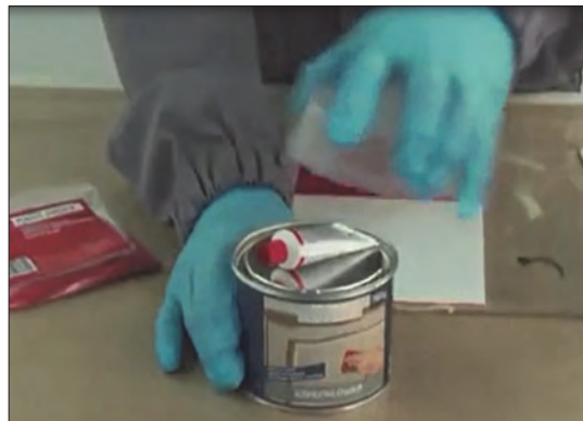
شکل ۵۵- دو جزء بتونه سنگی و مخلوط کردن آنها
